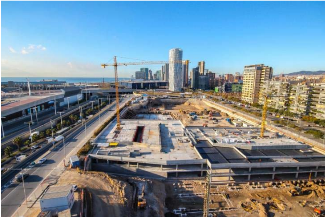
Panorámica de las obras del Campus Diagonal Besòs
